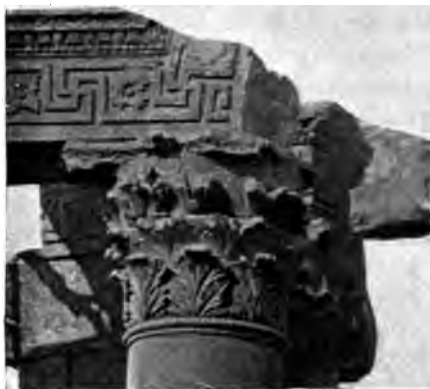
112. Kapitell von dem Tempel zu Atil mit dem Ansatz des Bogens zwischen den beiden mittleren Säulen.
